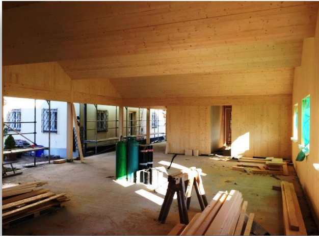
Innenraum Richtung Eingang
