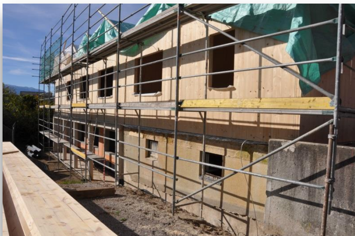
Blick vom Kinderspielplatz auf den Neubau
